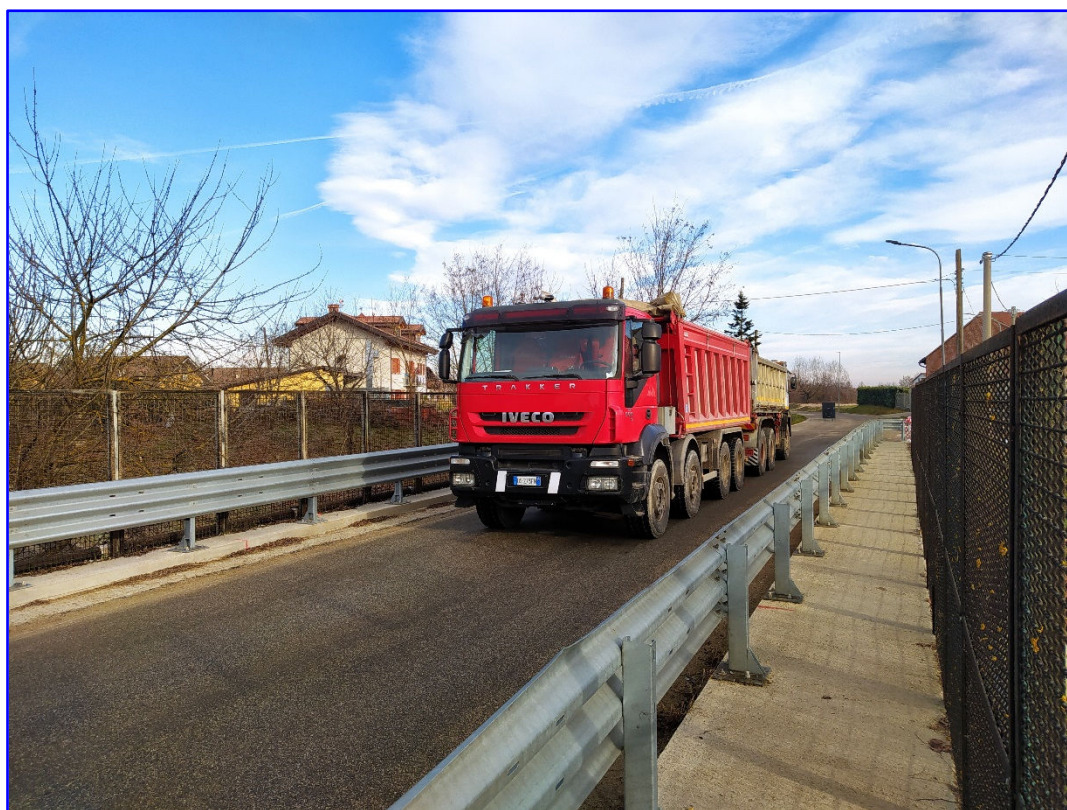
Vista degli autocarri 1 e 2 con gli assi posteriori verso la mezzeria del ponte
