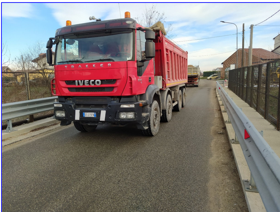
Vista dell'autocarro 2 con gli assi posteriori nella mezzeria del ponte
