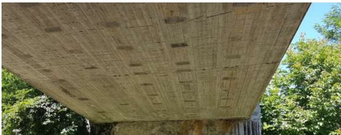
Figura 6.5 – Ammaloramenti impalcato
