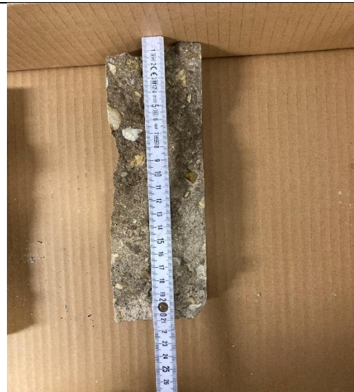
Rilievo profondità penetrazione ioni cloruro CAR3
