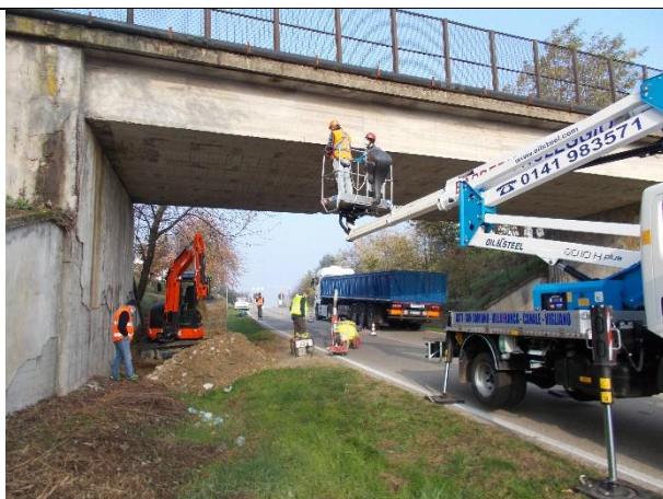
Area di cantiere
