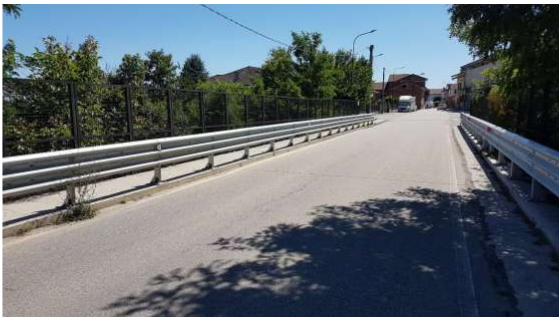
Figura 4.5 – Vista del sovrappasso dal suo estradosso
