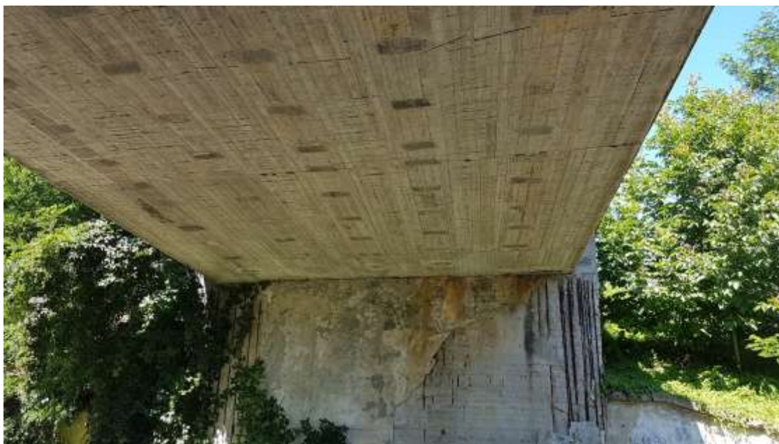
Figura 4.6 – Vista dell'intradosso soletta
