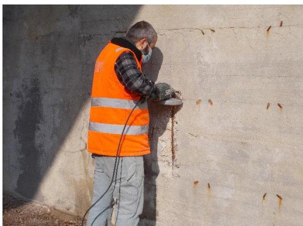
Esecuzione prelievo barra acciaio A1 – Spalla2
