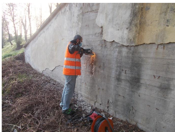
Esecuzione prelievo barra acciaio A1 – Spalla1
