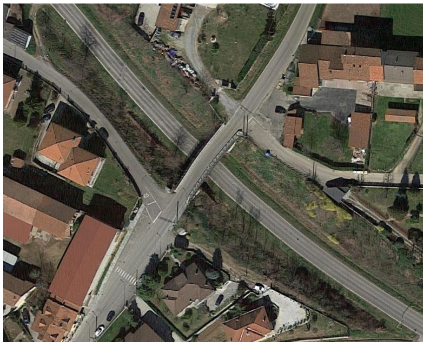
Ortofoto Sovrappasso sulla S.P 19 al km 30+480
