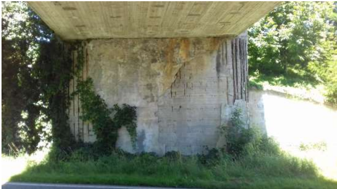
Figura 4.3 - Spalla lato Dusino San Michele vista dalla S.P. 19
