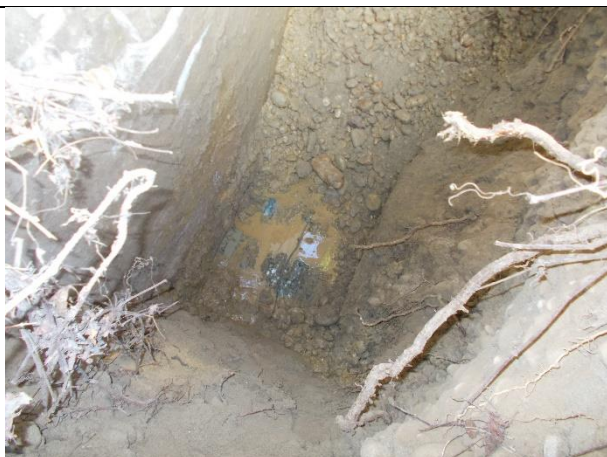
Estradosso scarpa di fondazione Spalla1
