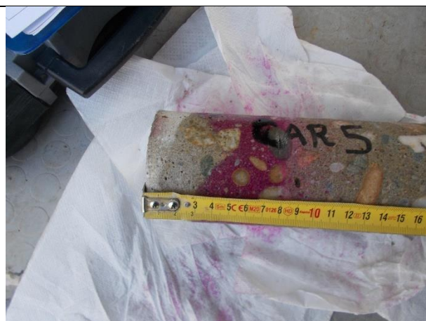
Profondità di carbonatazione CAR1 – 3,5cm
