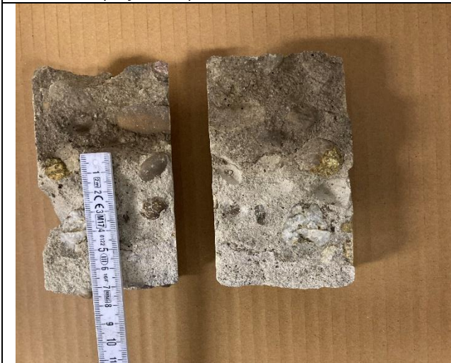
Rilievo profondità penetrazione ioni cloruro CAR4
