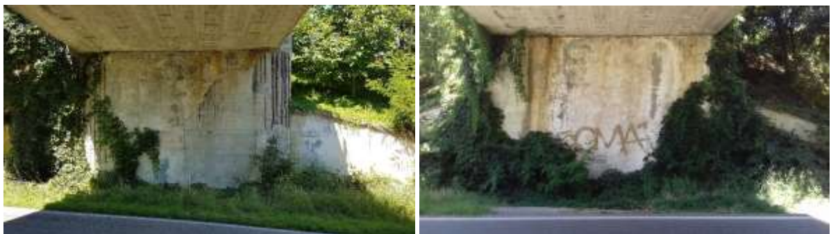
Figura 6.4 – Ammaloramenti spalle
