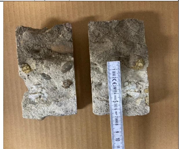
Rilievo profondità penetrazione ioni cloruro CAR4
