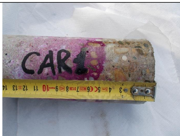
Profondità di carbonatazione CAR1 – 4,5cm
