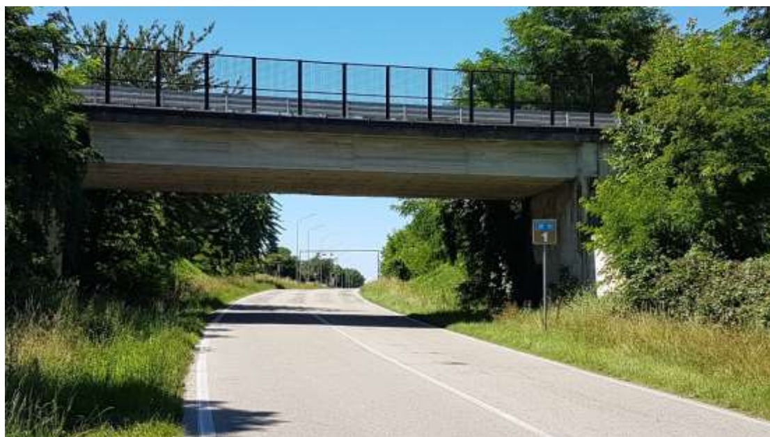
Figura 4.2 - Vista del sovrappasso dalla S.P. 19
