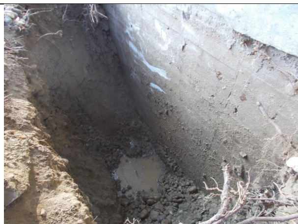
Scavo di fondazione – Profondità 200cm
