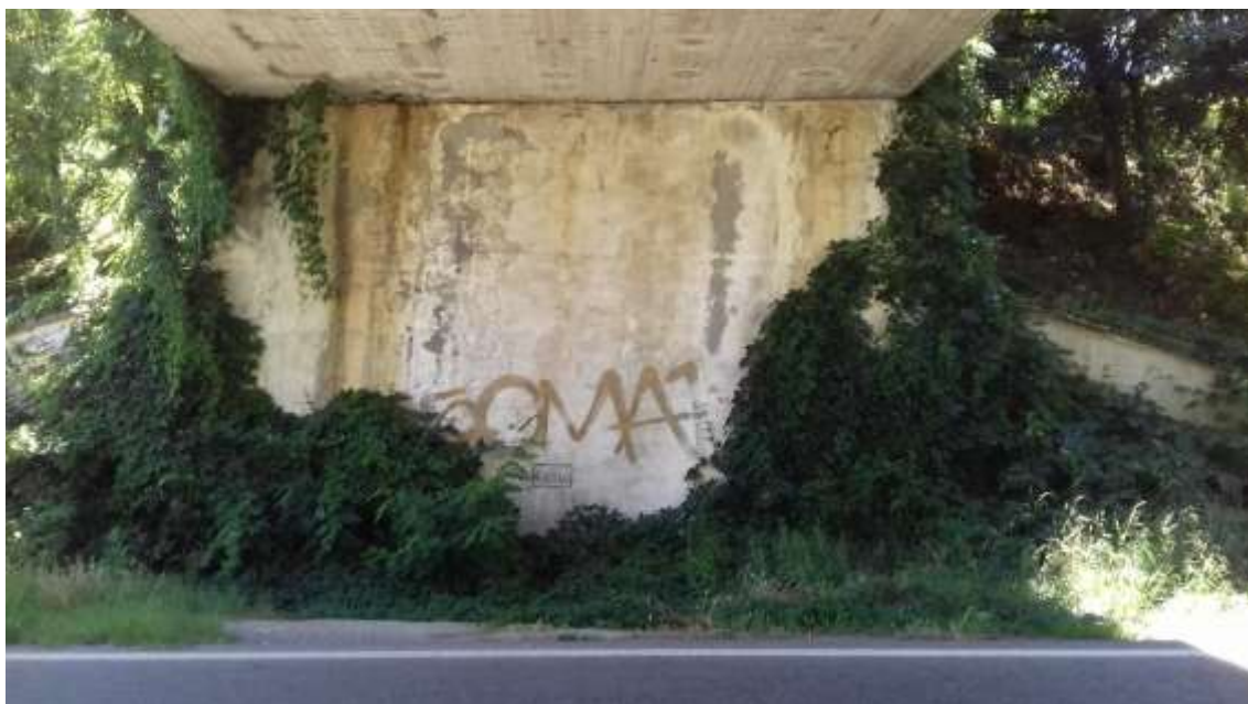
Figura 4.4 - Spalla lato Cellarengo vista dalla S.P. 19
